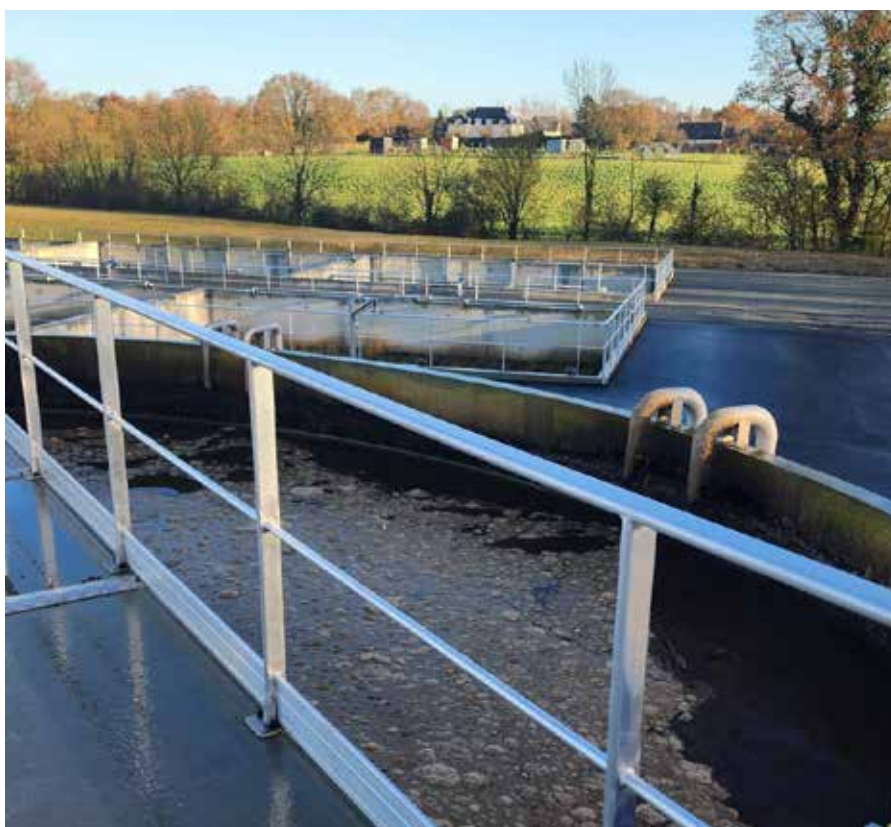
Station d'épuration de Saint-Léger-des-Bois
